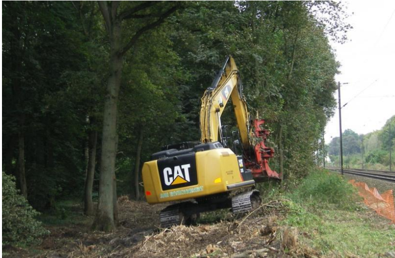
Abattage mécanisé d'une zone nécessitant une « remise à niveau ».
