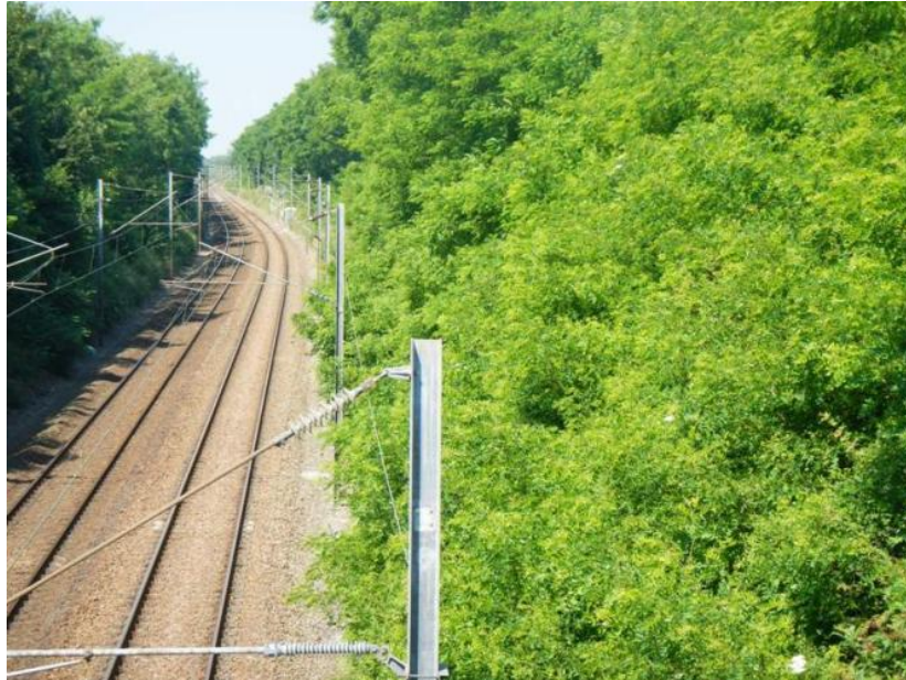
Exemple de dépendances vertes du réseau ferré national nécessitant une remise à niveau
