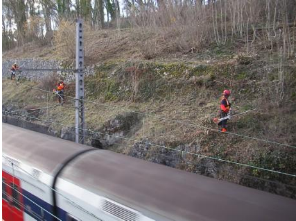
Des zones du RFN ne peuvent pas être mécanisées : exemple d'un débroussaillage manuel encordé sur voies circulées.
